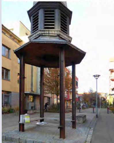
Glockenturm - Blick nach Nordwesten
